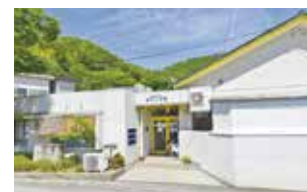
障害者支援施設 あかりの家
